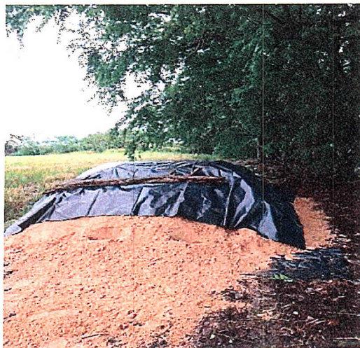
SUMINISTRO DE ARENA - MOSTERO FLUIDO PARA INYECTAR ENTRE EL TUBO DE POLIETILENO Y EL TUNEL
