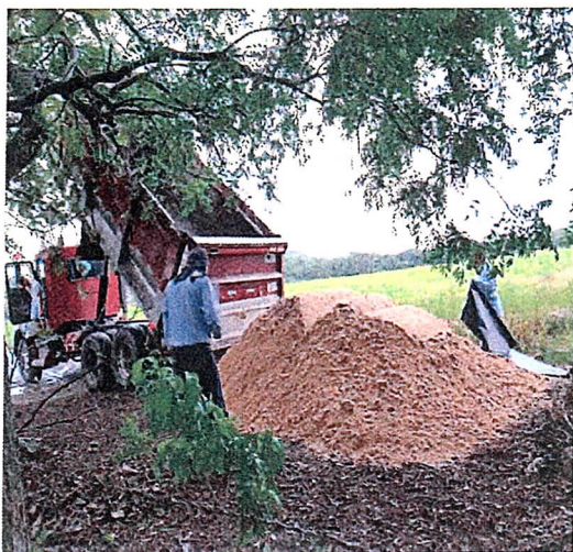
SUMINISTRO DE ARENA - MOSTERO FLUIDO PARA INYECTAR ENTRE EL TUBO DE POLIETILENO Y EL TUNEL
