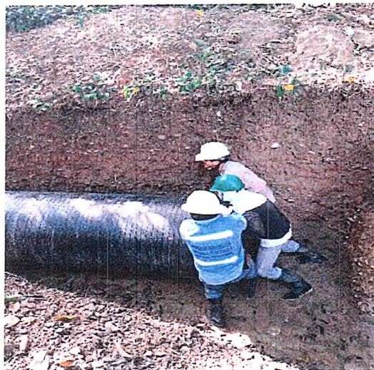
INSTALACION DE LA TUBERIA EN POLIETILENO
