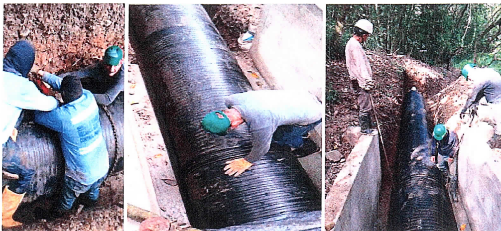
SELLADO DE LA TUBERIA EN POLIETILENO
