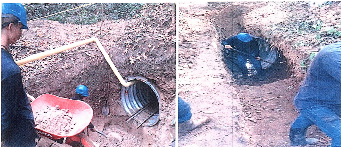
PERFORACION EN SISTEMA TUNEL LINER (ENTRADA Y SALIDA TUNEL)
