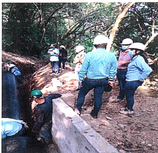
INSTALACION DE LA TUBERIA EN POLIETILENO
